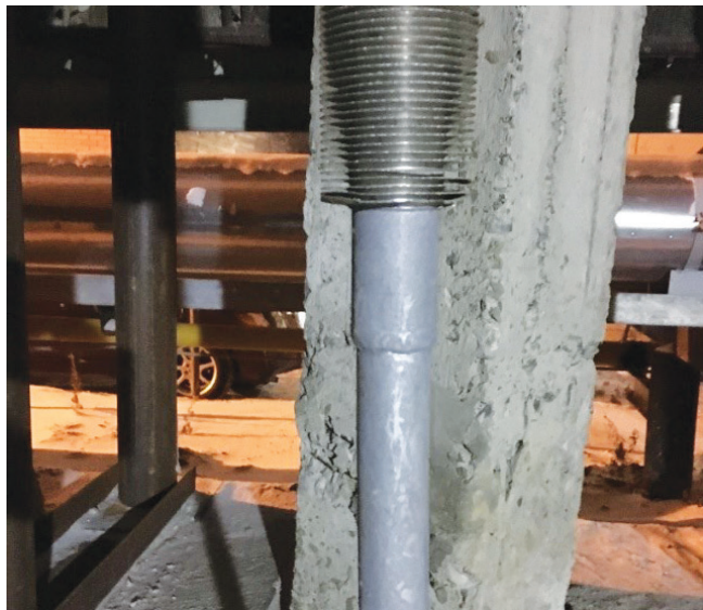
Рис. 5. Термостабилизатор около свай
