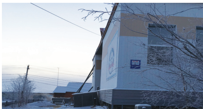
Рис. 1. Неравномерная осадка здания Ямальского агроэкономического колледжа
