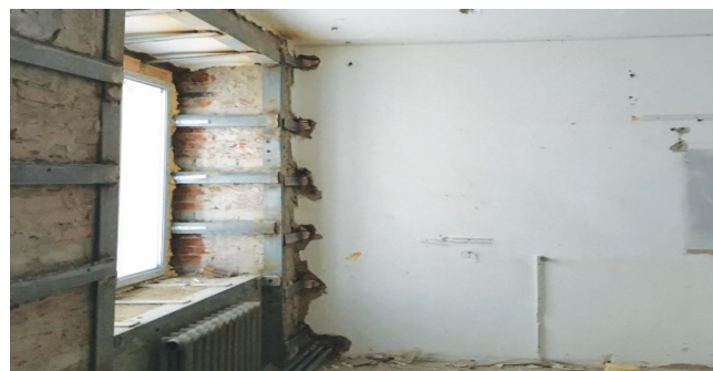
Рис. 4. Укрепление конструкции здания
