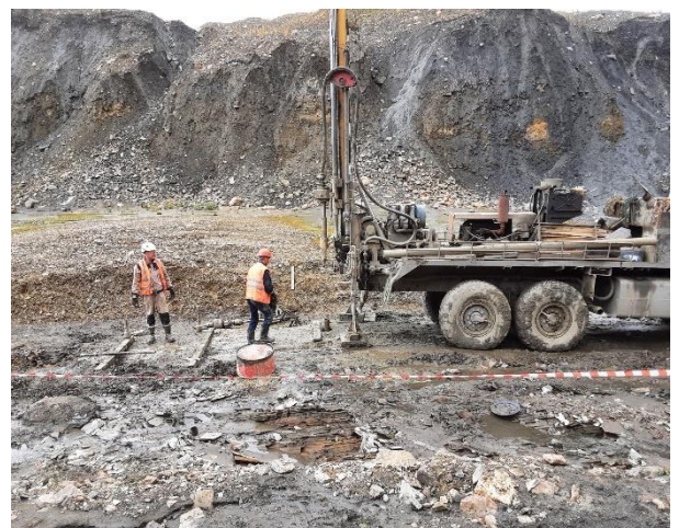
Проведение испытаний на стандартную пенетрацию
