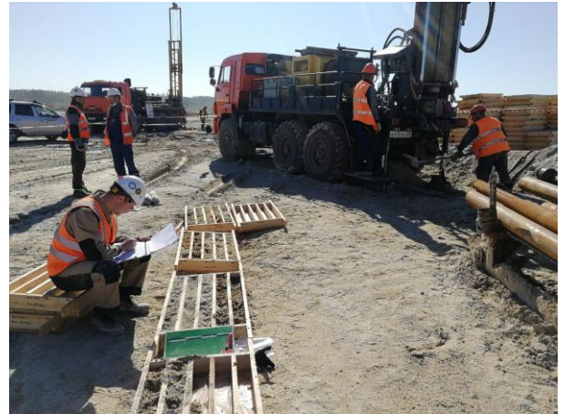
Бурение инженерно-геологических скважин
