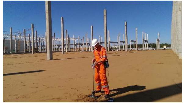
Проведение испытаний динамическим плотномером
