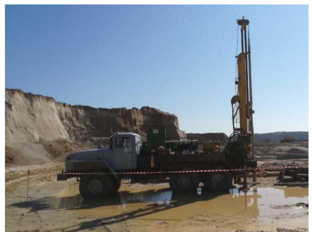
Бурение гидрогеологических скважин
